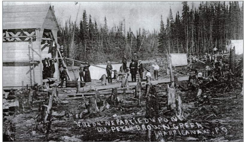
↑ 1914, construction du pont couvert
