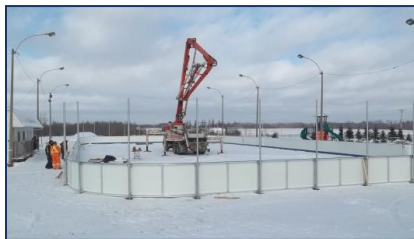
Mercredi le 18/12/2013 : mise au niveau de la structure et bétonnage des poteaux.
