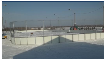
Jeudi le 19/12/2013 : installation des grillages et fin des travaux 16 h.
